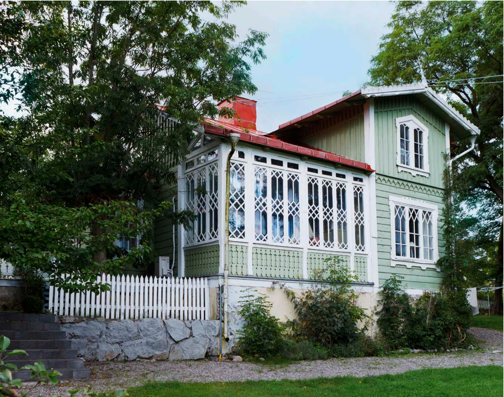
Bakom de spröjsade fönstren ligger vardagsrummet – här var den ursprungliga glasverandan. Fasaden är k-märkt och får inte målas om i någon annan kulör.
